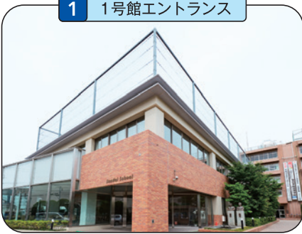
1 1号館エントランス
